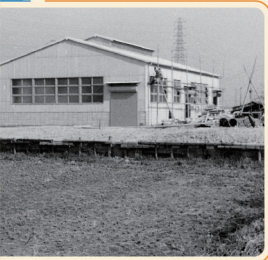
▲ 창업 당시의 공장 외관
